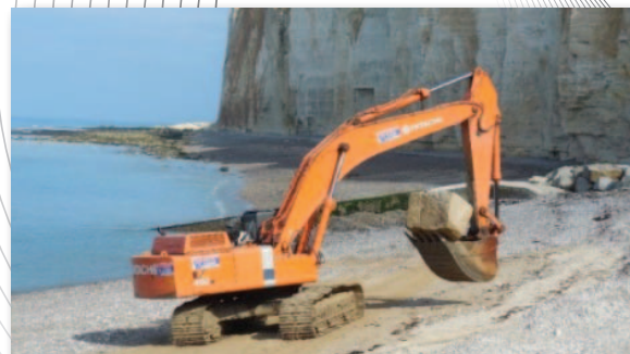
Enrochements 2 à 7 tonnes CG 76 – Marché pluriannuel
